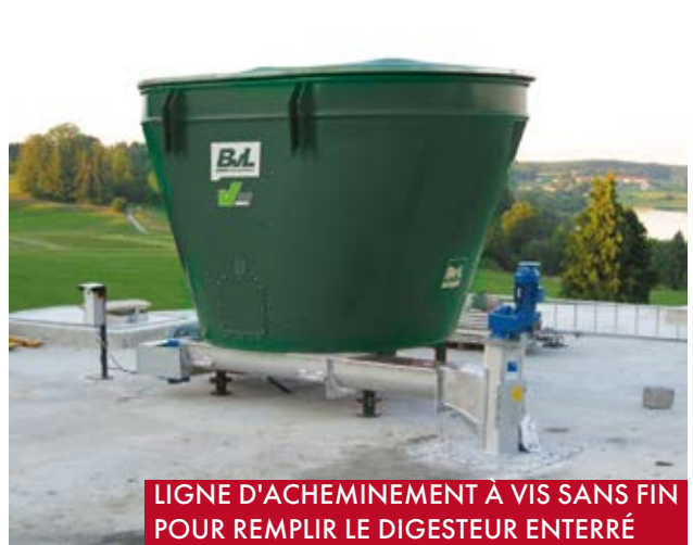
LIGNE D'ACHEMINEMENT À VIS SANS FIN POUR REMPLIR LE DIGESTEUR HAUT
