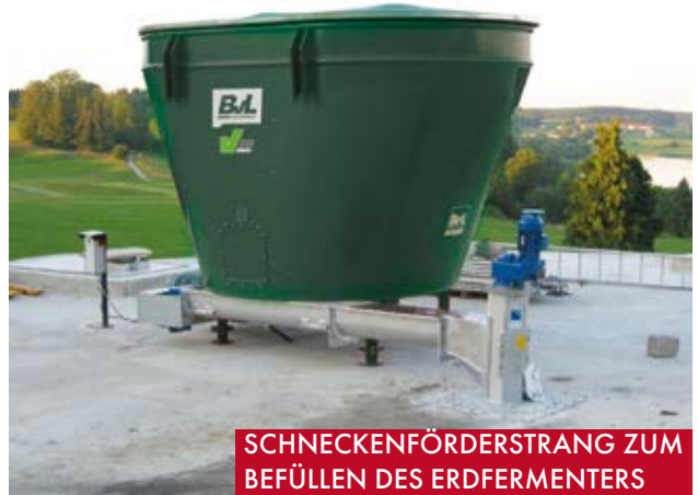
SCHNECKENFÖRDERSTRANG ZUM BEFÜLLEN DES HOCHFERMENERS
