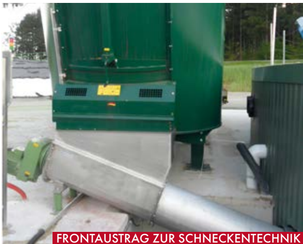
SCHNECKENFÖRDERSTRANG ZUM BEFÜLLEN DES HOCHFERMENERS
